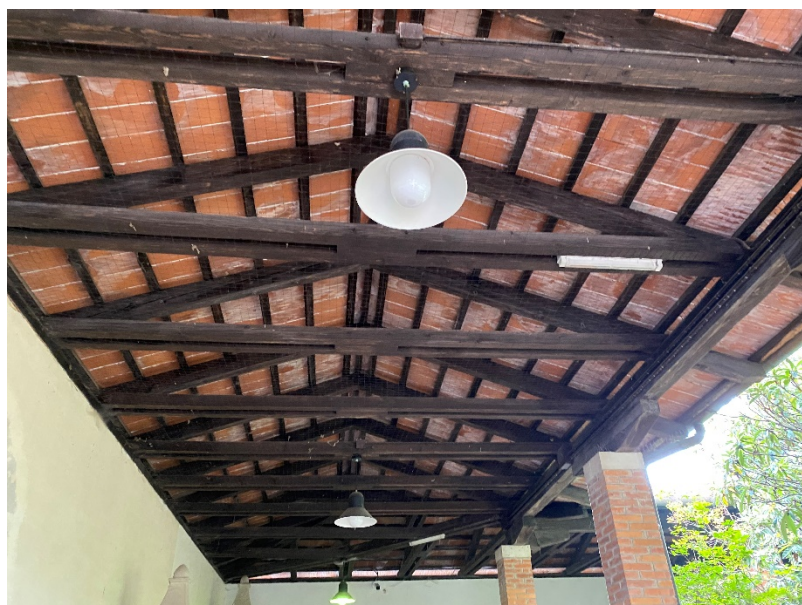
18. Vista soffitto, sistema di illuminazione
