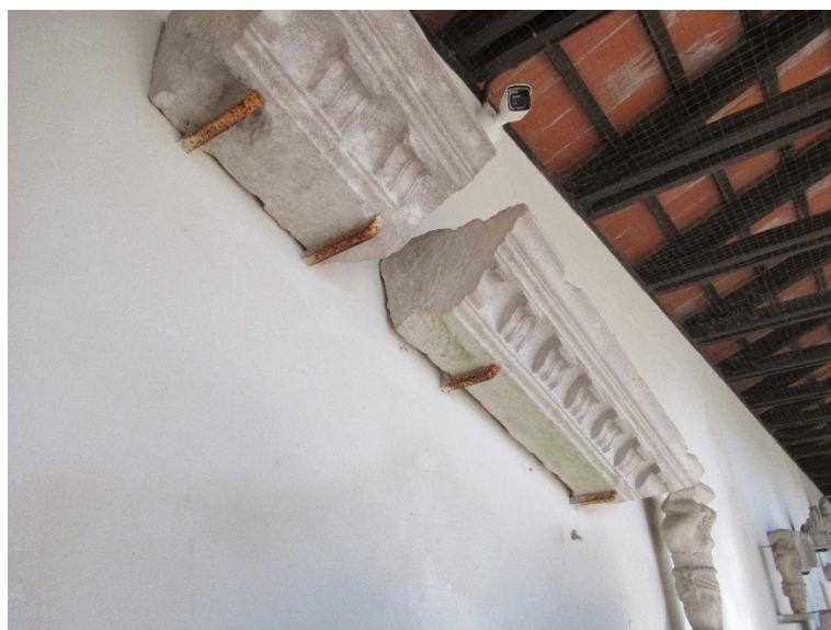
14. Dettaglio elementi metallici di sostegno
