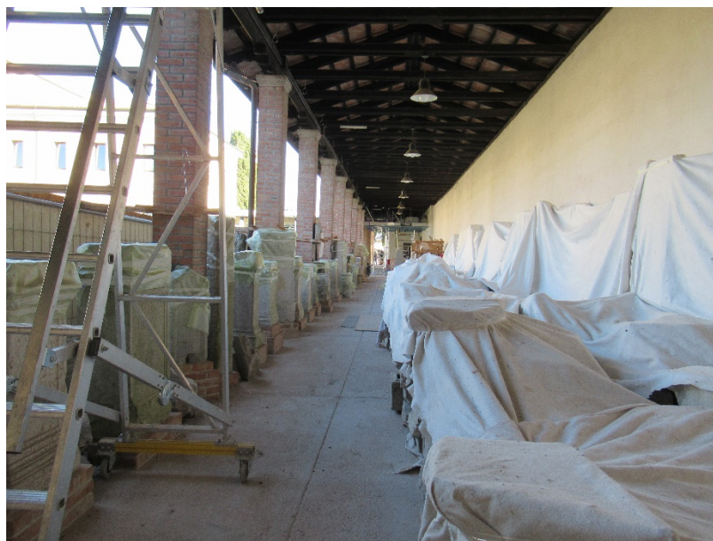
11. Vista Stralcio 7, in fase di cantiere
